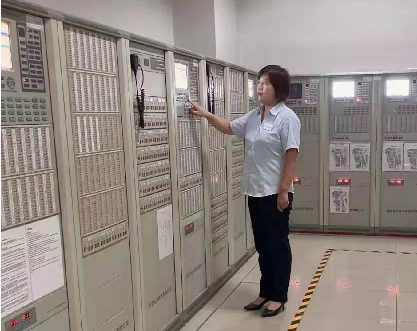
践行者 | 张洪云 石家庄勒泰中心（塔楼）
